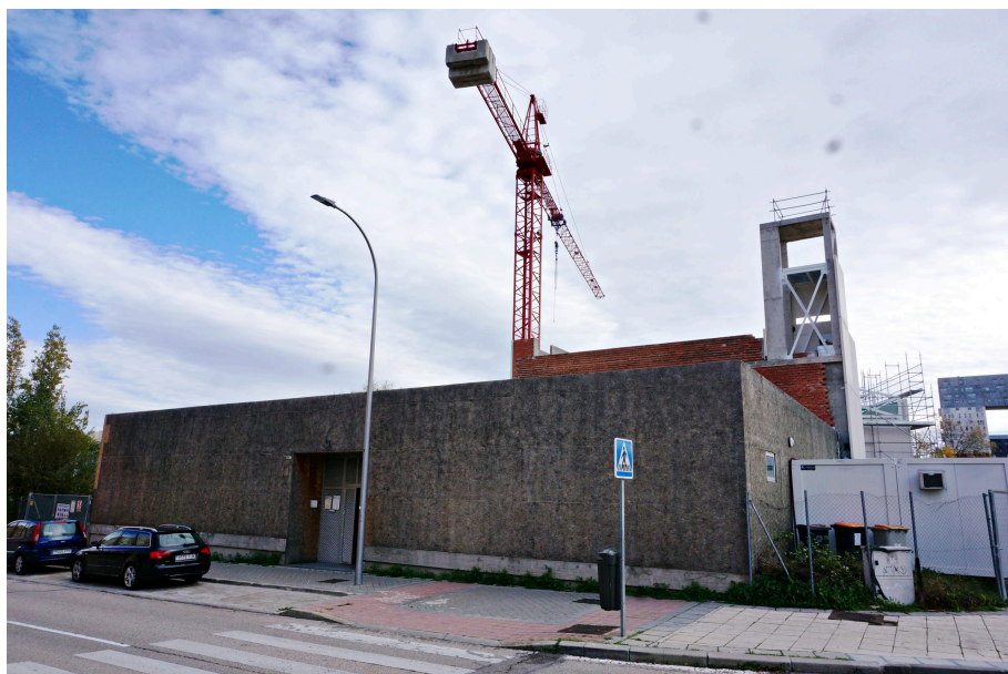
Estado actual de las obras en la parroquia San Rafael Arnaiz de Sanchinarro. ÁNGEL SÁNCHEZ
